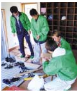
材料チェックをして、手すりを設置!
