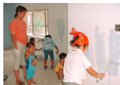
みんなで「みなくるハウス」の壁塗り
