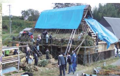
笹葺き古民家再生プログラム、 笹葺き民家の修繕
