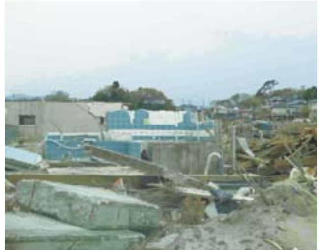
相馬市沿岸の被災地の様子
